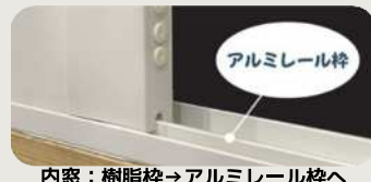
内窓：樹脂枠→アルミレール枠へ
